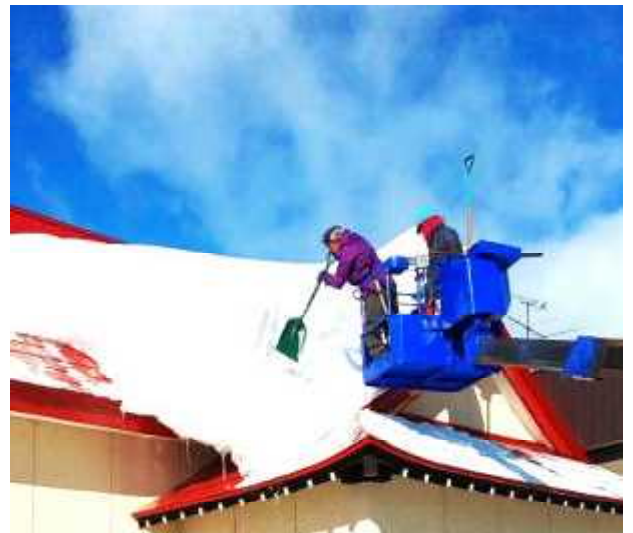
高所作業車を使用して安全に雪下ろし。
