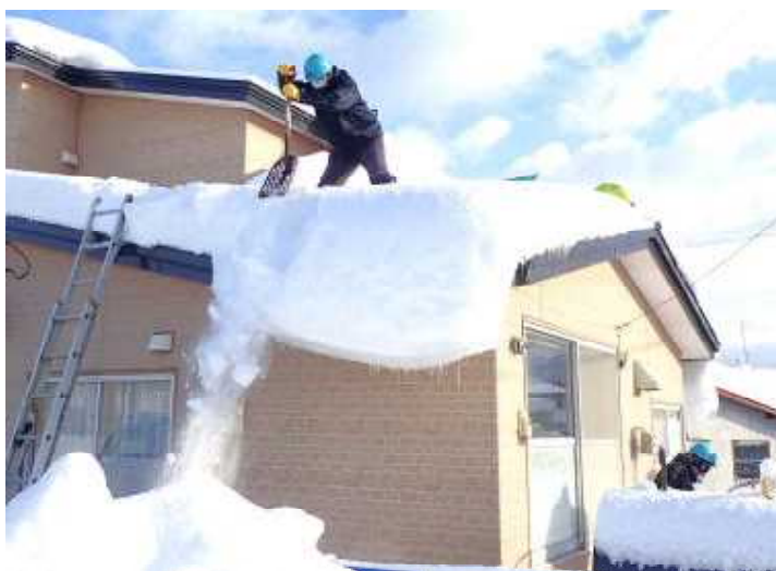
安全面に配慮し上下で声を掛け合い作業を進める。
